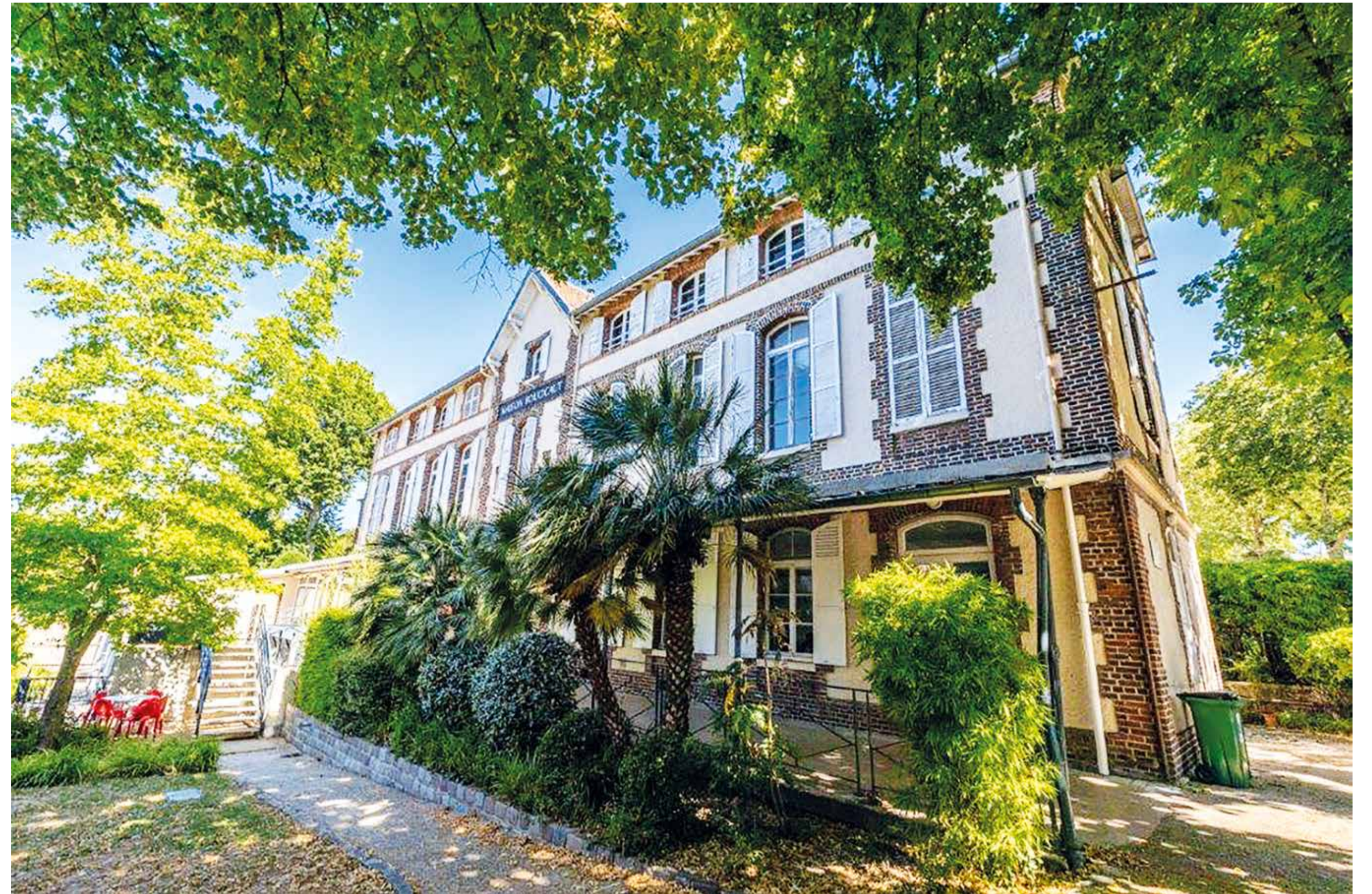
▲ Maison des Entrepreneurs - Fontenay-aux-Roses
