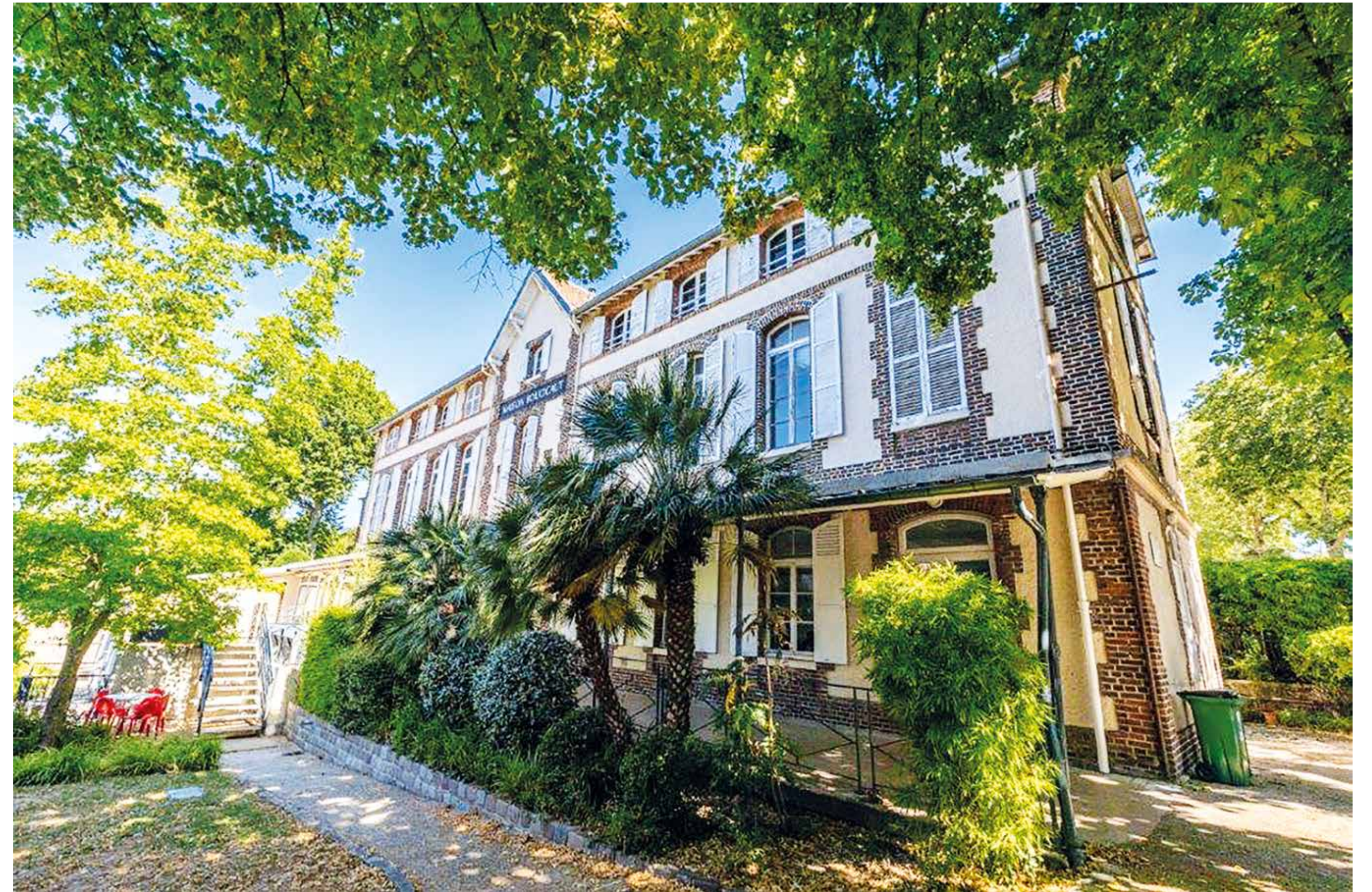
▲ Maison des Entrepreneurs - Fontenay-aux-Roses
