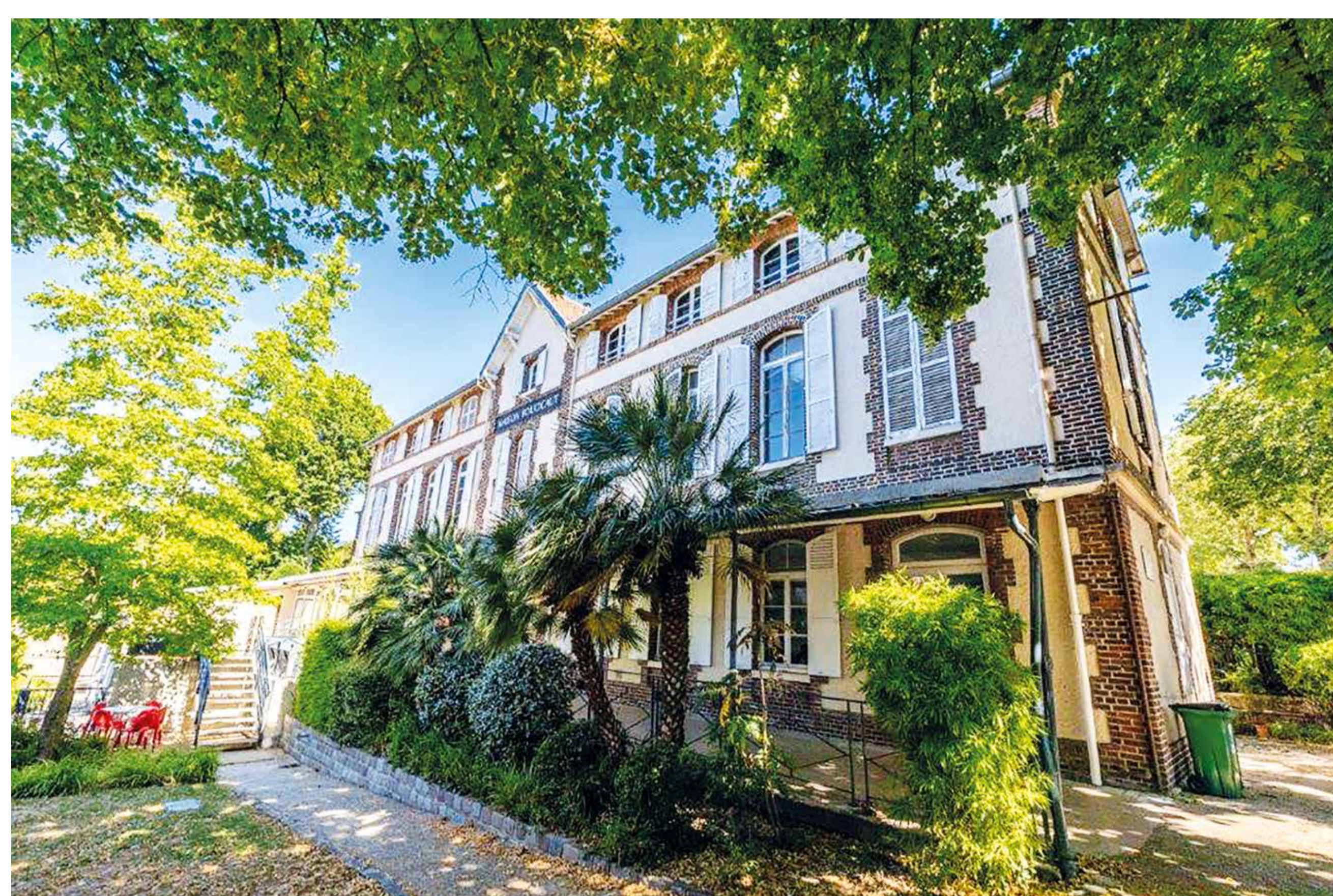
▲ Maison des Entrepreneurs - Fontenay-aux-Roses
